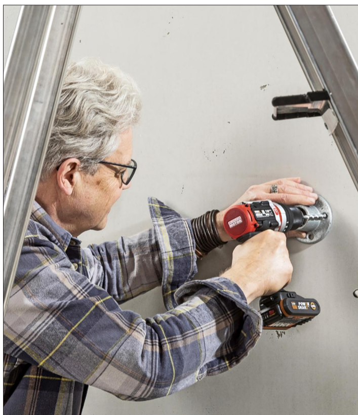
Für das Bohren in Beton braucht man einen Bohrerschrauber mit Schlag - er unterstützt das Bohren mit einer kräftigen rhythmischen Schlagbewegung.
